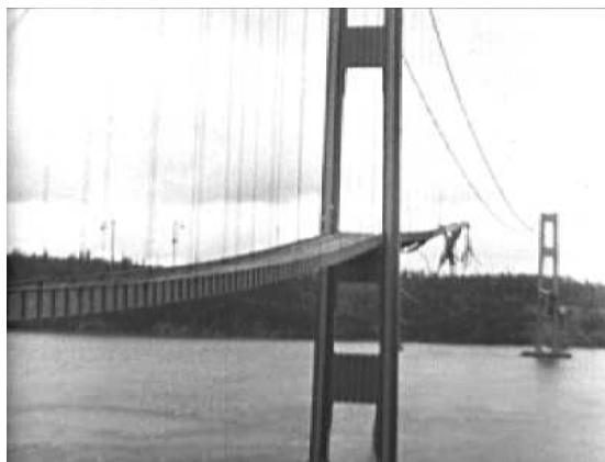
Abbildung 5.7: Die Tacoma Narrows Bridge nach ihrem Einsturz im Jahre 1940. Bildnachweis: Wikipedia.
